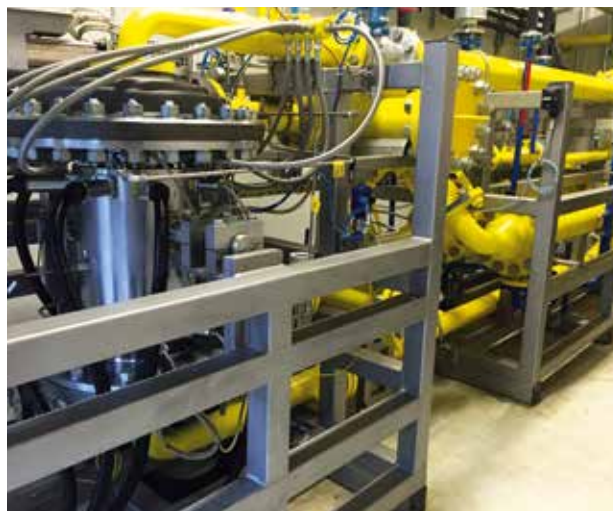
Der 200 kW-Generator befindet sich in der Mitte der Gasentspannungsturbine FIMA GET 200 (vorne links).
